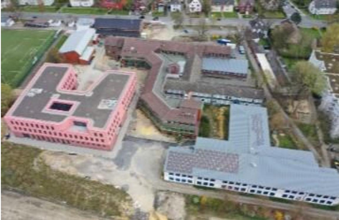
*Nach dem Abriss der alten Gebäude wird im April 2023 die Bodenplatte für unser Gebäude B gegossen. Die ersten Module werden aufgestellt.*
